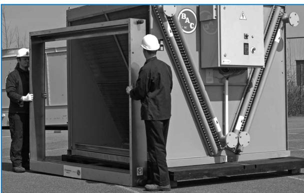
*Einbau des leeren Vorkühlerrahmens am gerät.*
