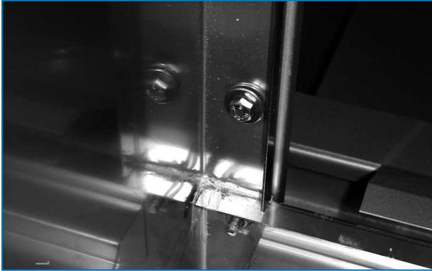
*Edelstahlschrauben und Muttern, die den Vorkühlerrahmen an den Gerätflanschen befestigen.*
