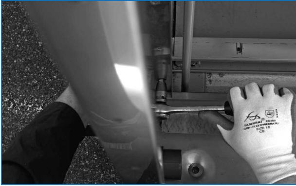
*Befestigen des Vorkühlerrahmens mit Edelstahlschrauben am Gerät.*
